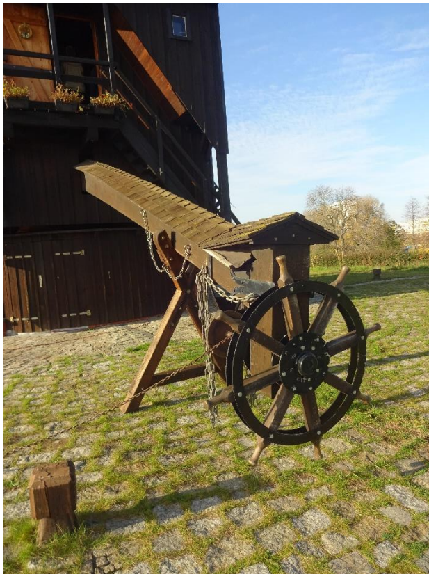
Abb. 13 + 14: Mit Hilfe des Sterts werden das Mühlengebäude und somit die Flügel in die gewünschte Position gebracht (manuelle Ausrichtung).
