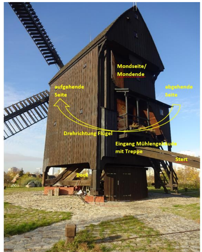
Abb. 8: Mondseite, aufgehende Seite, abgehende Seite (Letztere nicht sichtbar): ohne Schindeln (sondern Holzlaten)
