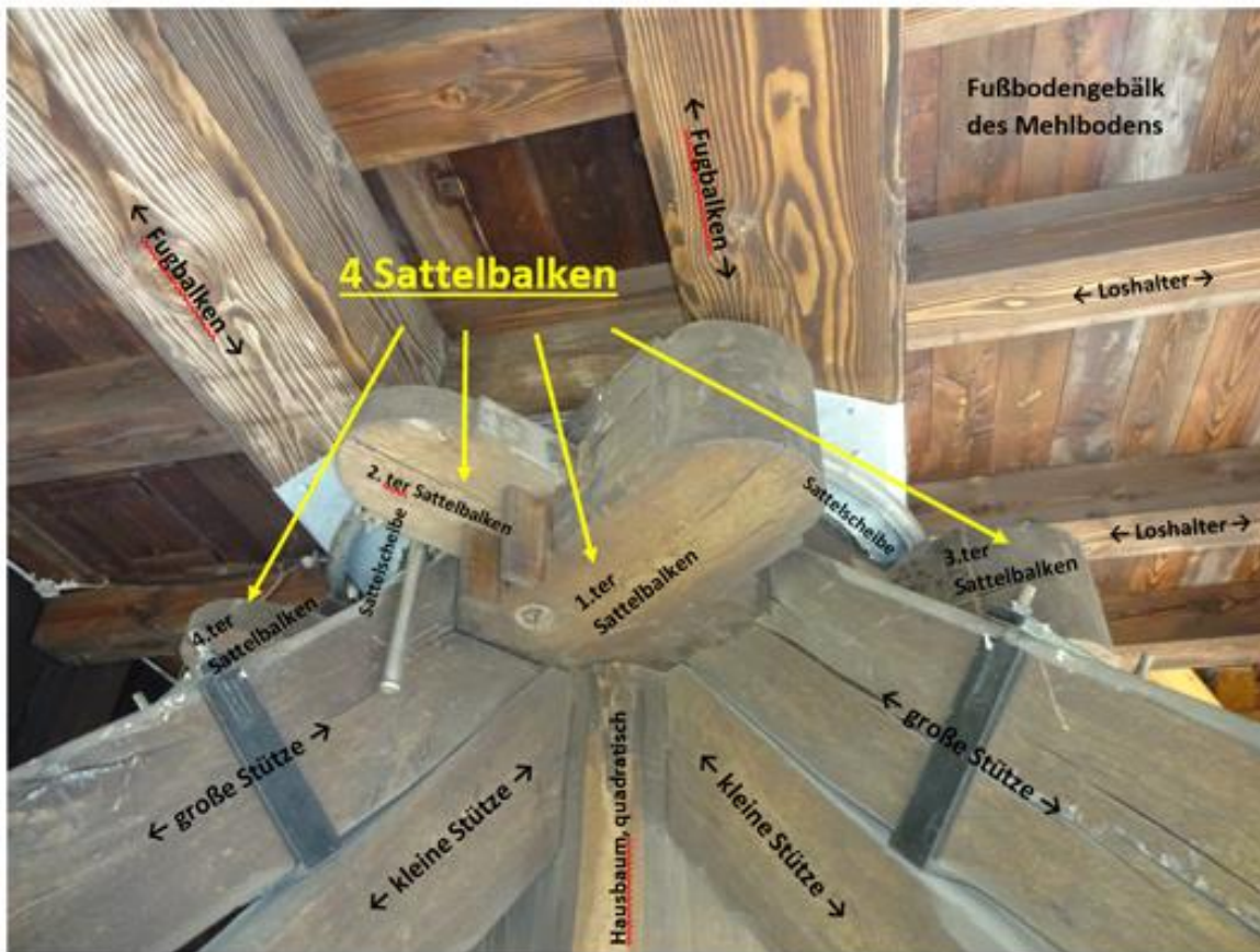
Abb. 10: Der Bock oberer Teil; Die Fugbalken gleiten auf der Sattelscheibe, wenn das Mühlegebäude in den Wind gedreht wird (Ausrichtung der Flügel). Die Sattelscheibe trägt dabei nur einen kleinen Teil des Kastengewichts (→ Seite 3).
