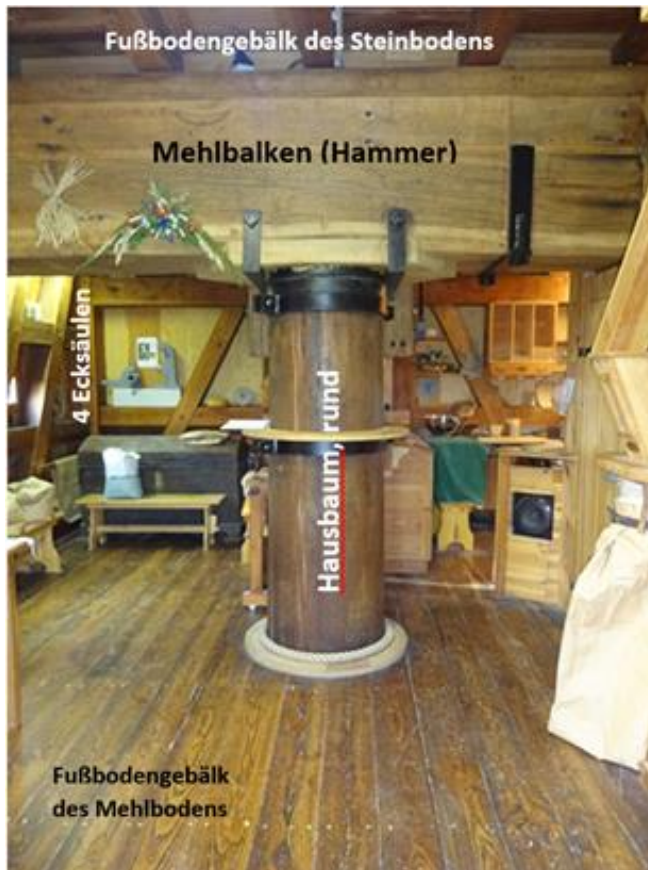
Abb. 12: der Hausbaum (rund) und der Mehlbalken auf dem Mehlboden
