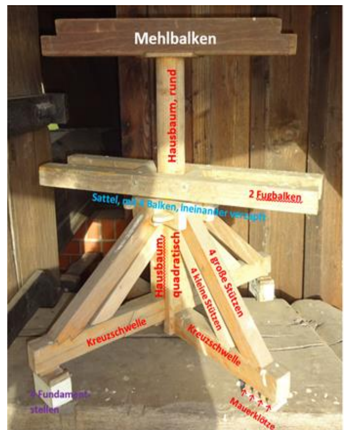
Abb. 9: Auf dem Gelände der Mühle Marzahn Modell des Bocks mit sämtlichen Holzelement
