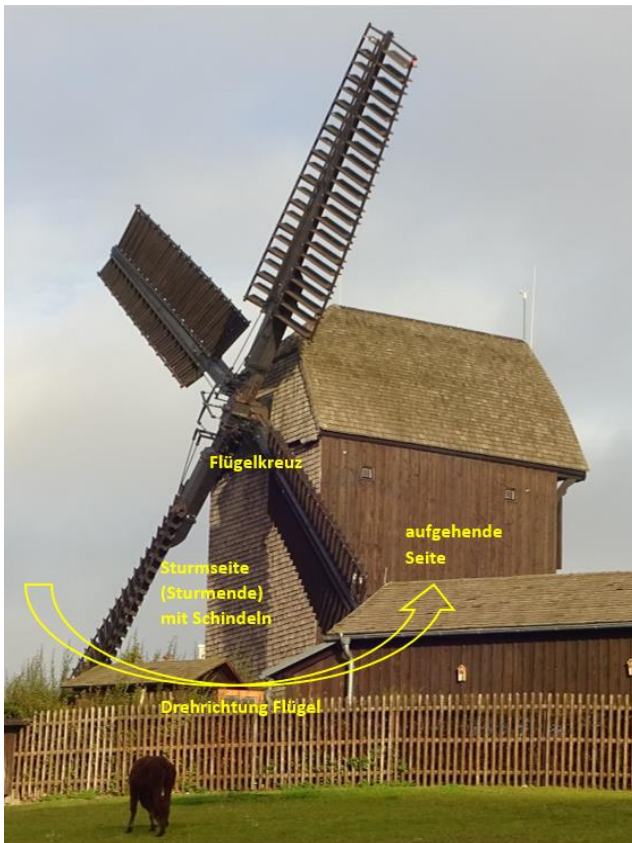
Abb. 7: Sturmseite mit Schindeln
