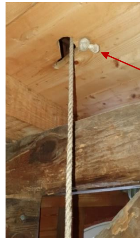
Decke vom Hebeboden
