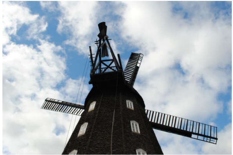
Wie gut das Müller Michael S. eine Kappe aufhat und so nochmal zeigen kann, wie das Zusammenspiel von Wind und Windrose dafür sorgt, dass die Flügel auch im Wind stehen.
